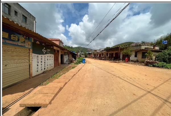
项目管网混凝土恢复（2023 年 8 月）
