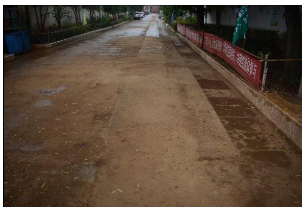
污水管管槽回填（2023 年 3 月）
