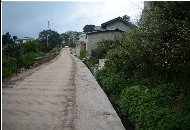
管槽采用混凝土恢复（2022 年 9 月）
