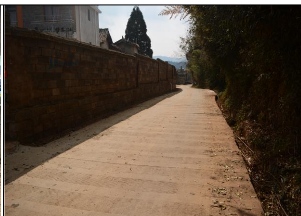
污水管管槽沥青回填（2023 年 6 月）
