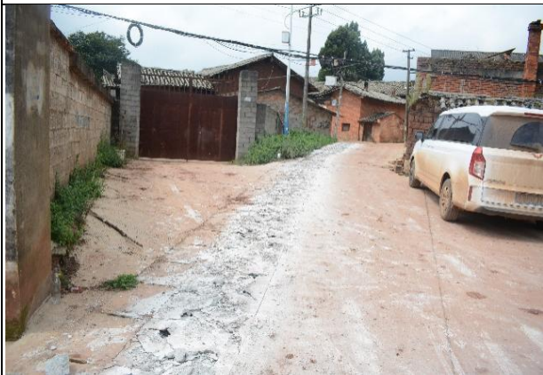
污水管管槽开挖（2022 年 9 月）
