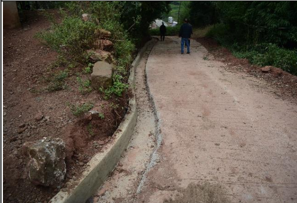
管槽采用混凝土恢复（2022 年 9 月）
