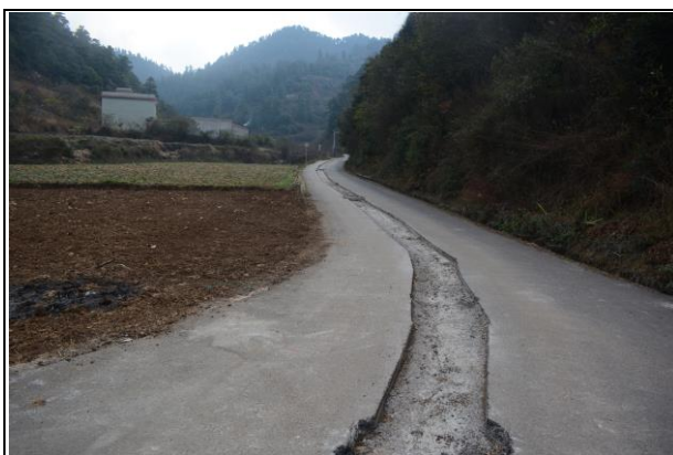
污水管管槽混凝土回填（2022 年 12 月）
