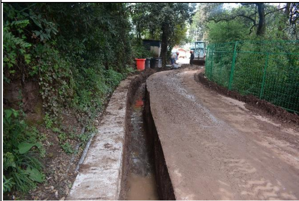
污水管管槽垂直开挖（2022 年 9 月）
