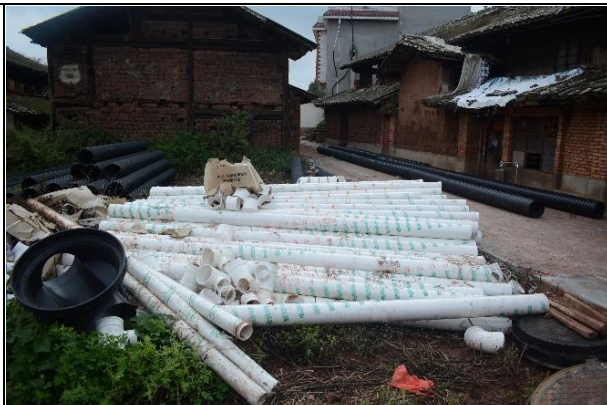
施工作业带-堆放材料（2022年9月）
