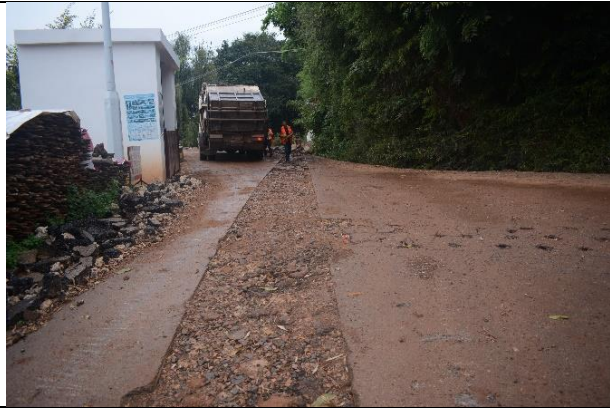
污水管管槽砂石回填（2022 年 9 月）
