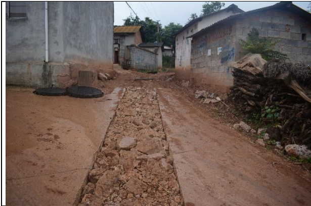
污水管管槽砂石回填夯实（2022 年 9 月）
