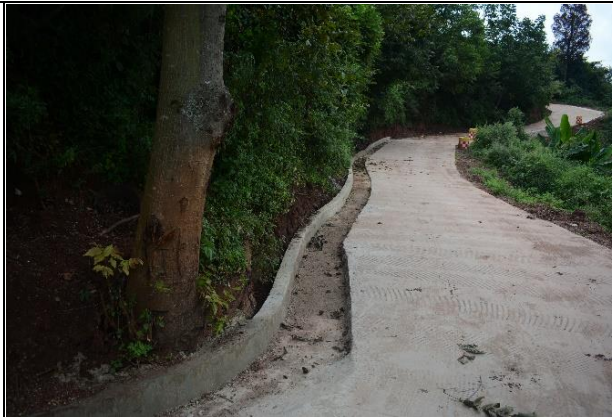
管槽采用混凝土恢复（2023 年 6 月）
