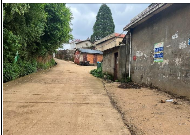
污水管管槽开挖前（2022 年 12 月）
