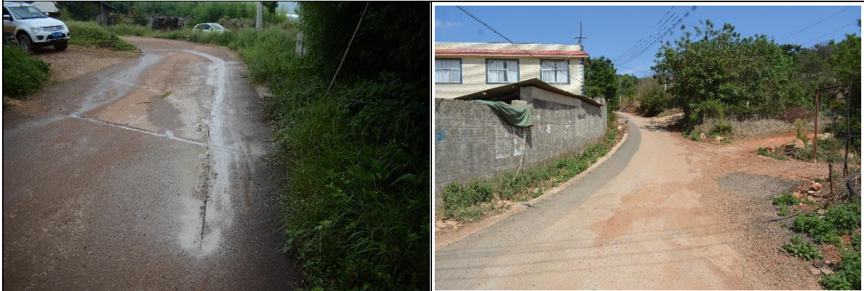
污水管管槽切缝（2022 年 9 月）
