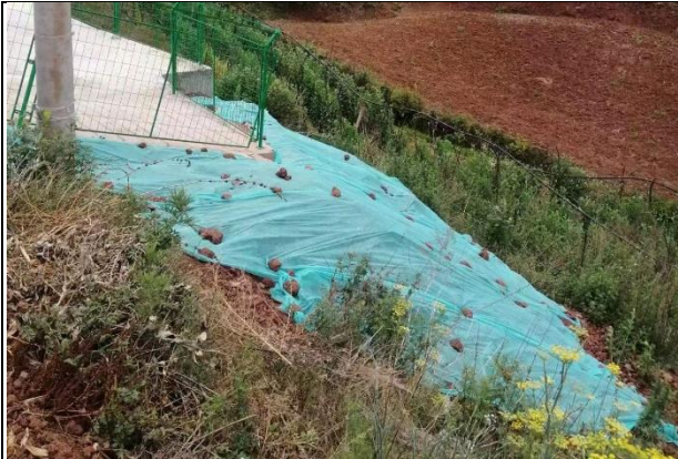
项目临时覆盖（2023 年 9 月）
