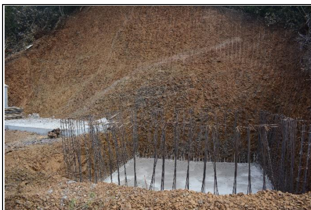
一体化污水处理设备（2022 年 12 月）
