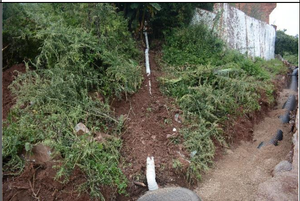
出户支管埋设（2022 年 9 月）
