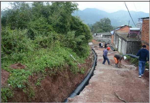
污水管网安装回填（2022 年 9 月）
