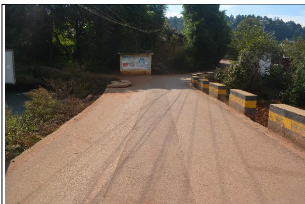
污水管管槽回填（2023 年 6 月）
