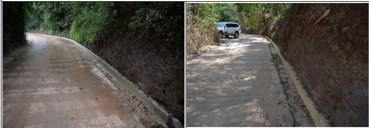
污水管管槽回填（2022 年 12 月）
