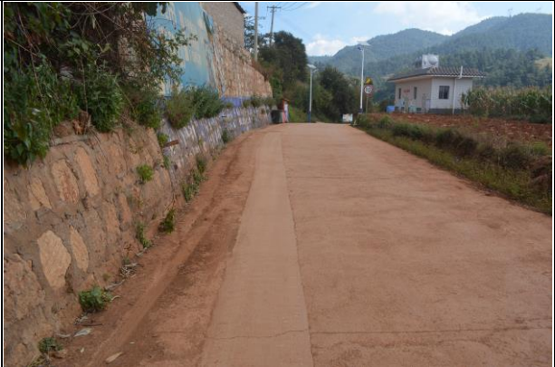
污水管管槽混凝土回填（2023 年 6 月）
