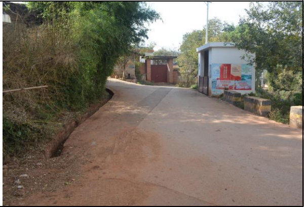
污水管管槽回填（2023 年 6 月）
