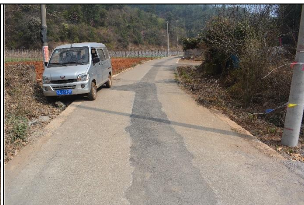
污水管管槽沥青回填（2023 年 6 月）
