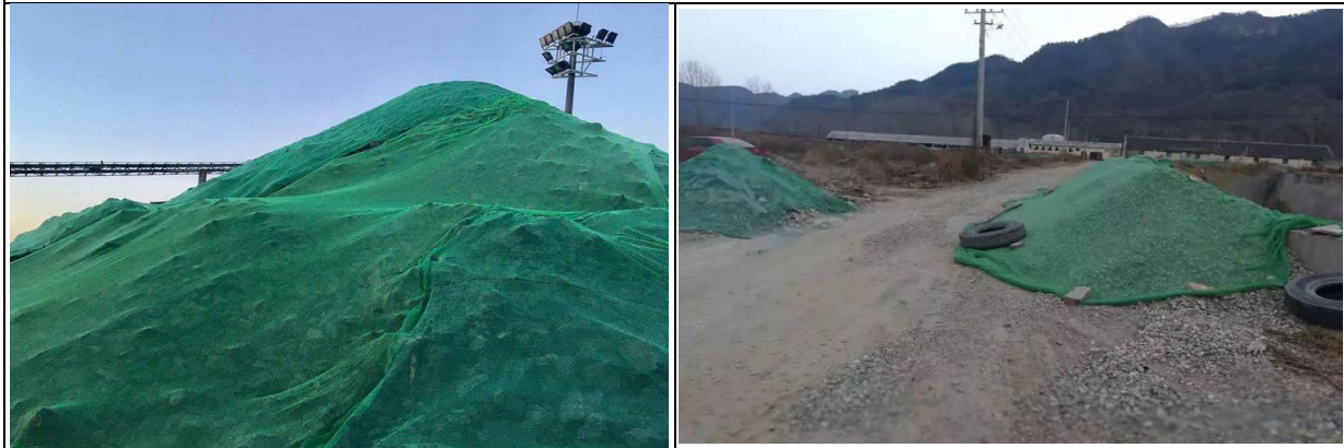
临时覆盖措施（2022 年 12 月）
