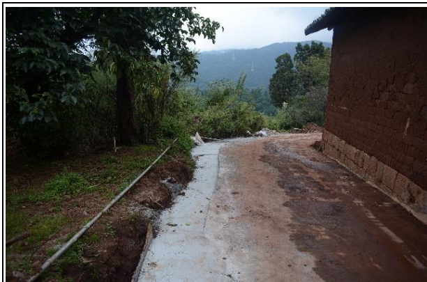
污水管管槽采用浆砌石回填（2022年9月）
