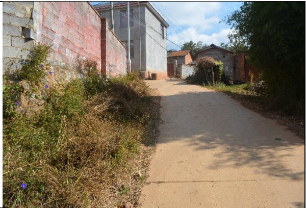
污水管管槽回填完（2023 年 6 月）
