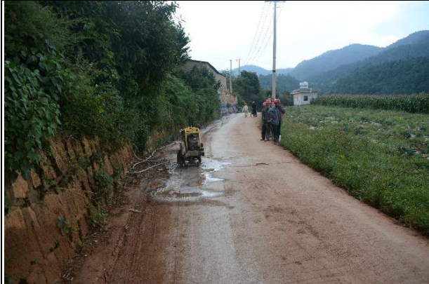
污水管管槽垂直开挖（2022 年 9 月）
