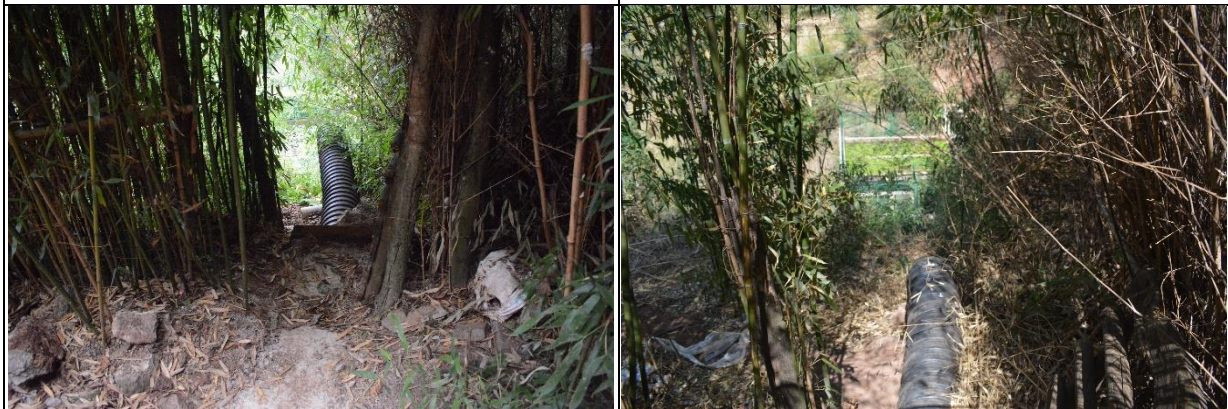
污水管管槽回填（2022 年 12 月）
