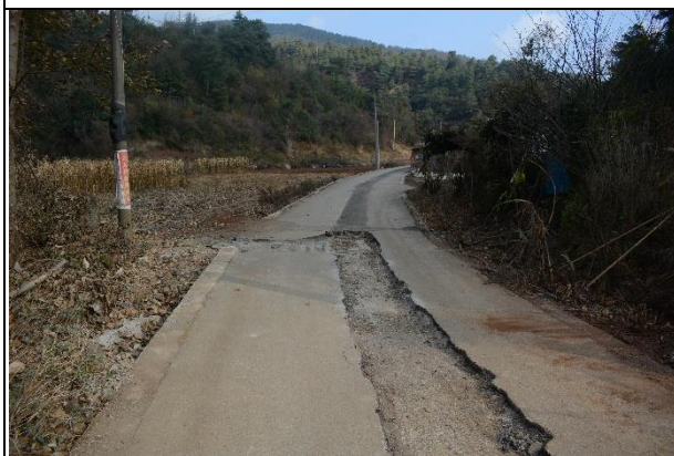
污水管管槽混凝土回填（2022 年 12 月）
