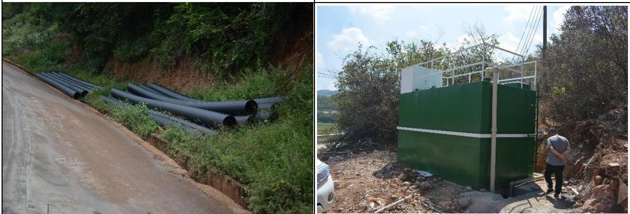
施工作业带堆放建筑材料（2022 年 12 月）
