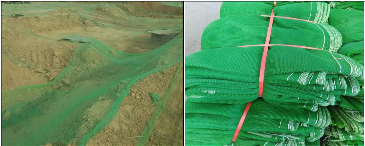
密目网临时覆盖措施（2022 年 12 月）
