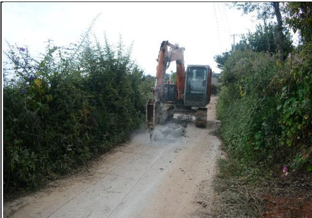
污水管管槽垂直开挖（2022 年 9 月）
