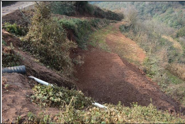
一体化污水处理站（2022 年 12 月）
