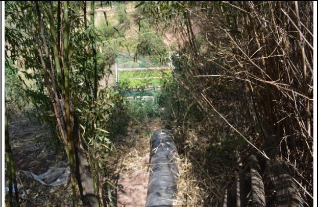
污水管管槽回填
