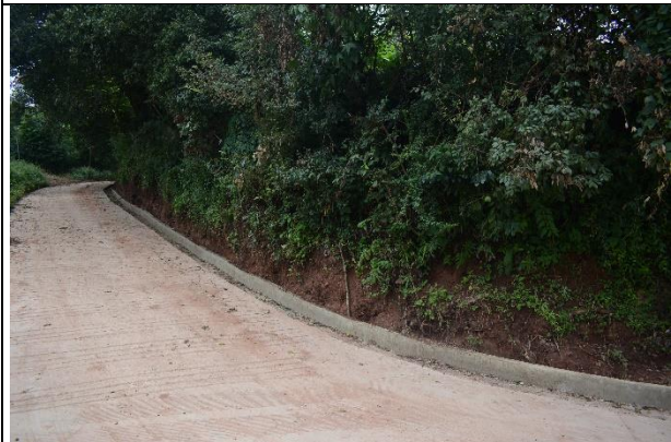
管槽采用混凝土恢复
