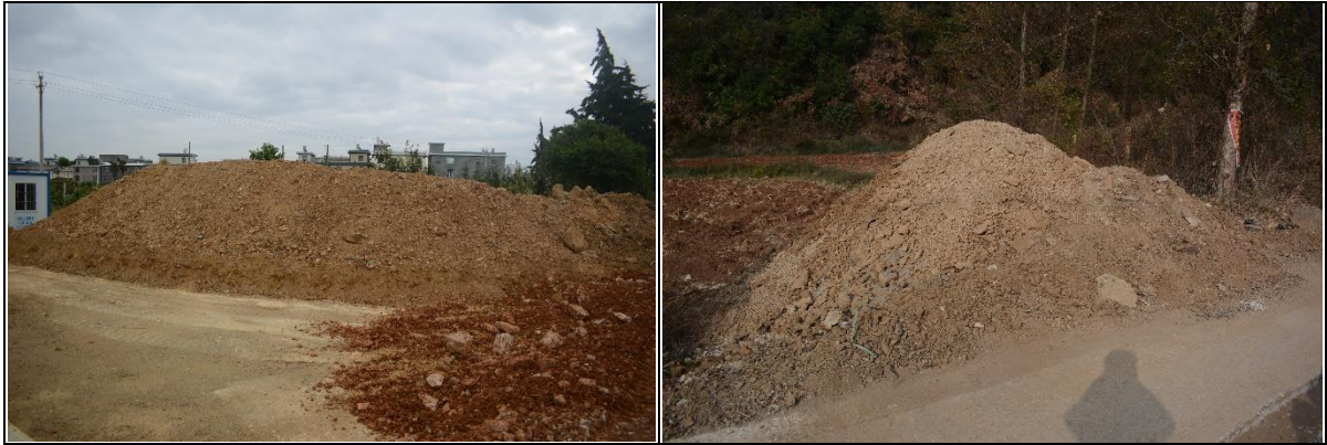
管网施工作业带周边堆存剥离表土
