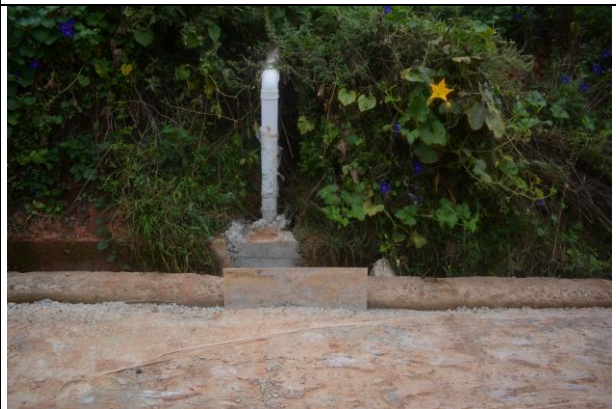
出户支管安装
