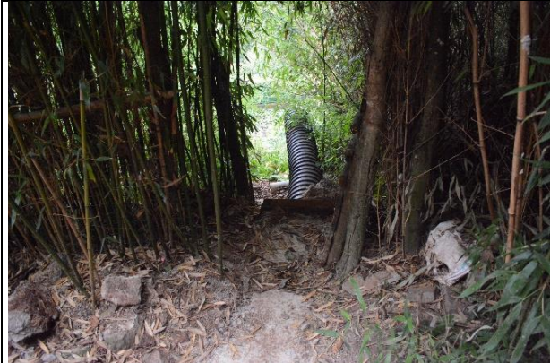
污水管管槽回填
