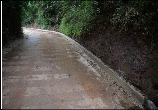
污水管管槽回填
