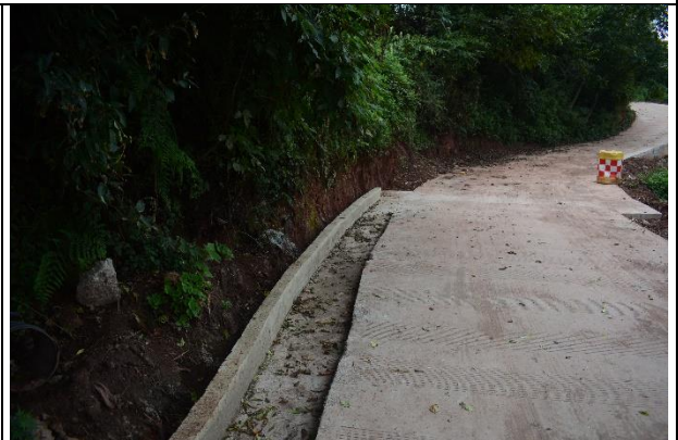
管槽采用混凝土恢复
