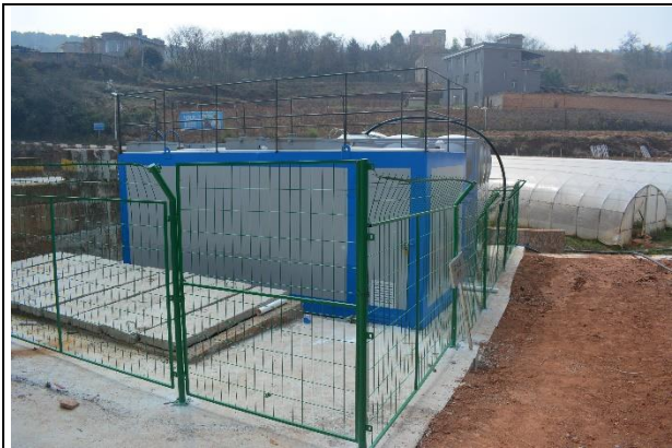
一体化污水处理站安装
