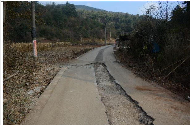
污水管管槽混凝土回填
