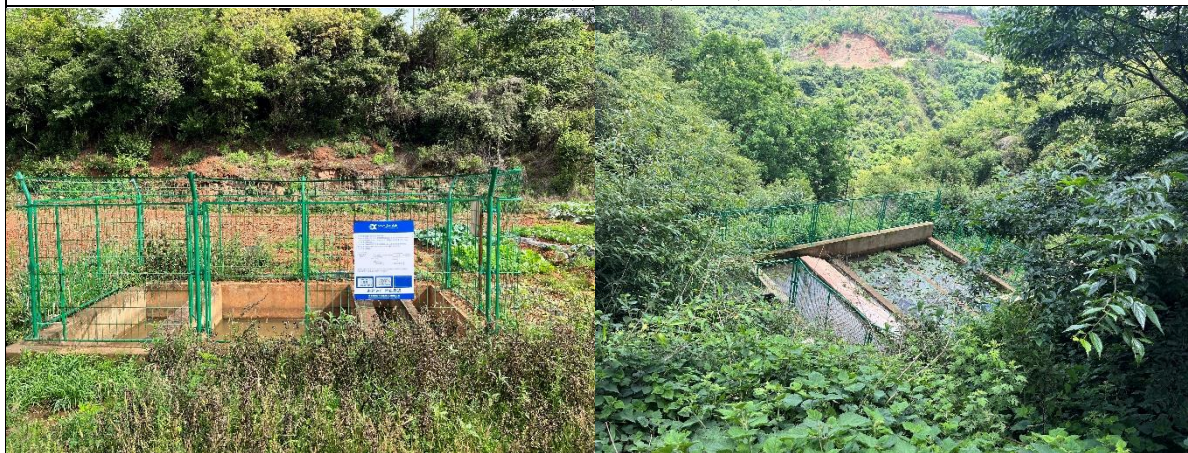
图 1-1 项目区氧化塘现状情况
