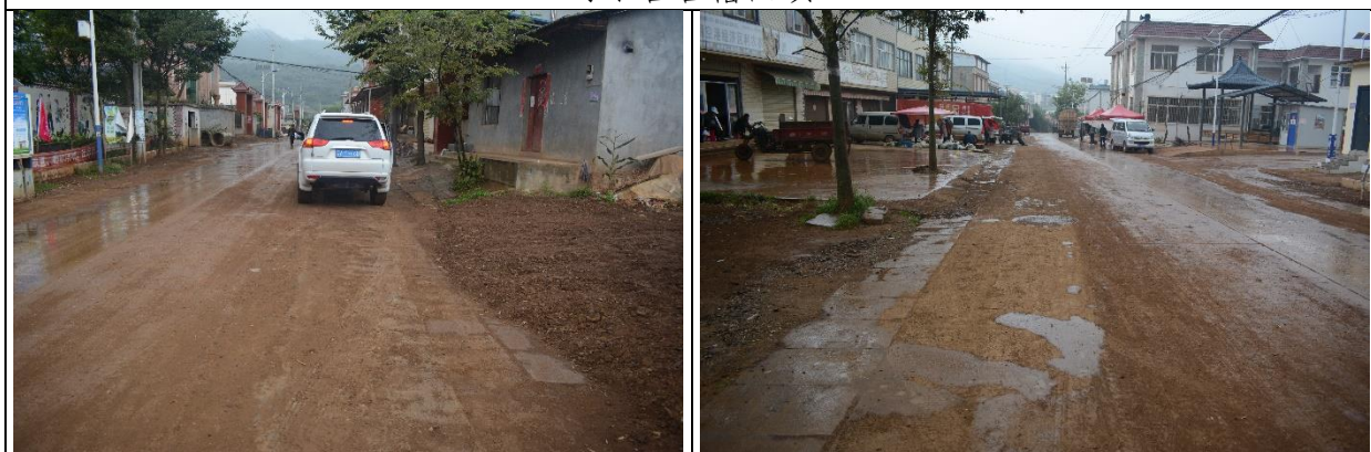
污水管管槽回填
