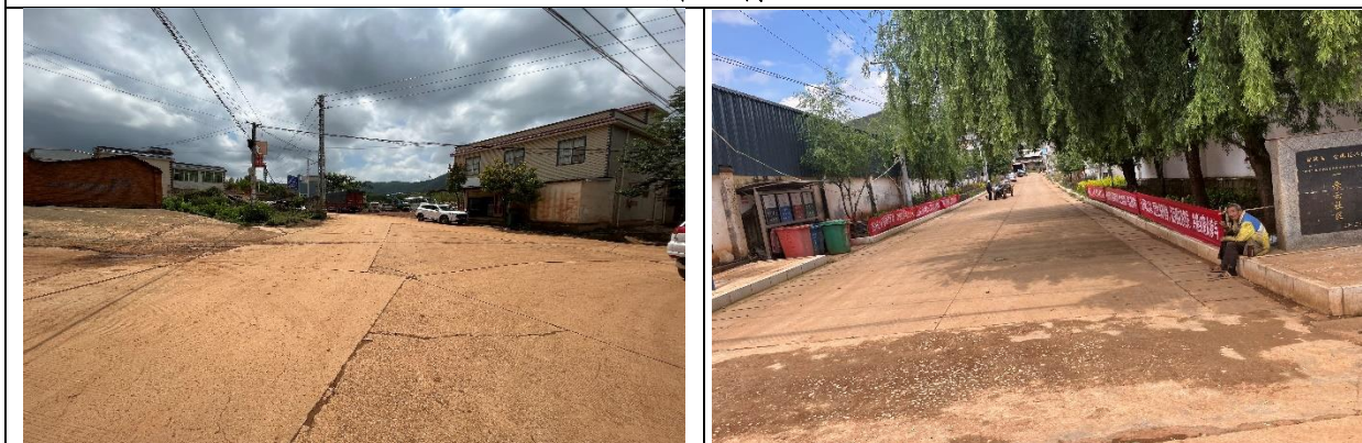
污水管管槽回填
