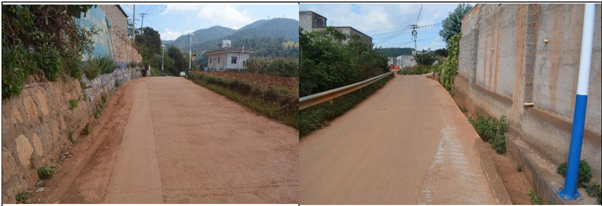
图 1-1 项目区污水管网开挖恢复现状情况-混凝土覆盖
