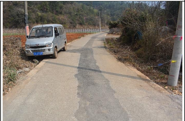
污水管管槽沥青回填
