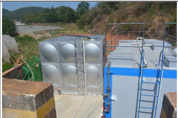
一体化污水处理站安装
