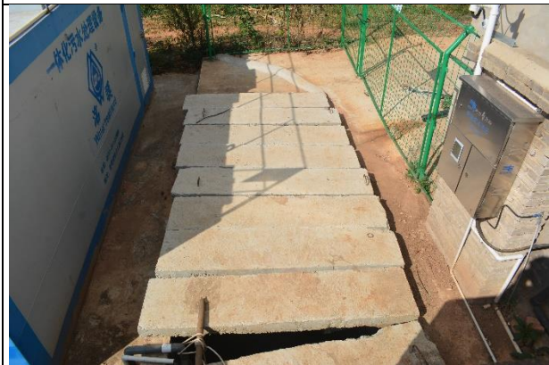
一体化污水处理站安装
