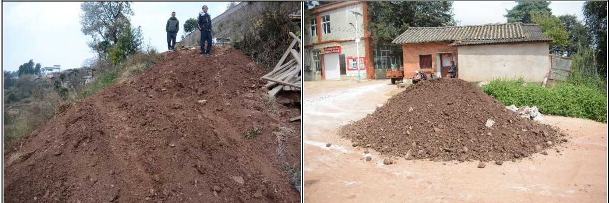
管网施工作业带周边堆存剥离表土
