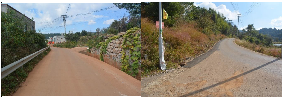
图 1-2 项目区污水管网开挖恢复现状情况-沥青混凝土覆盖
