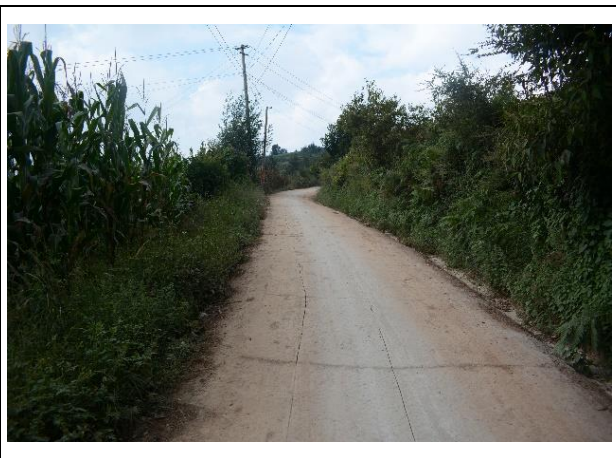
污水管管槽垂直开挖
