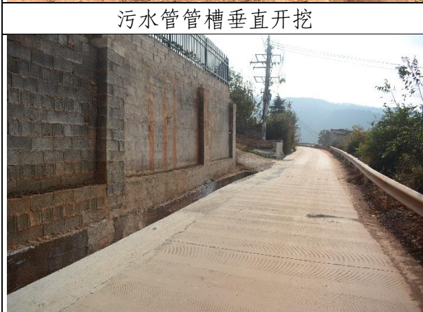
污水管管槽垂直开挖
