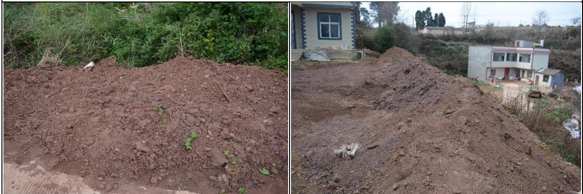
管网施工作业带周边堆存剥离表土
