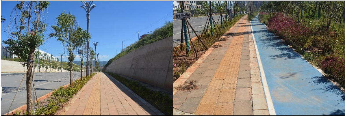
图 1-11 项目区透水铺装现在情况
