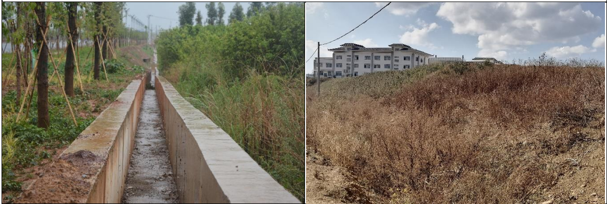
图 1-11 项目区排水现状情况
