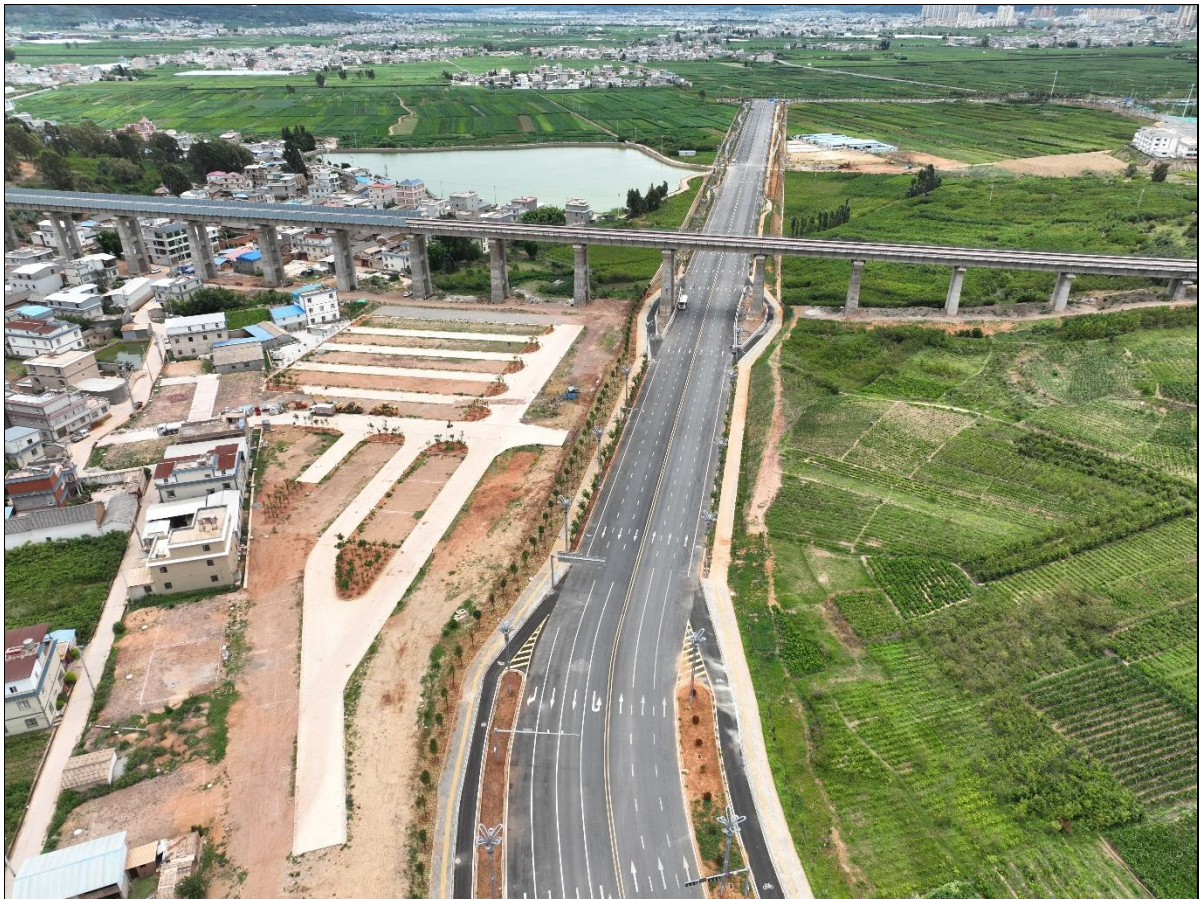
项目区道路路基路面现状
