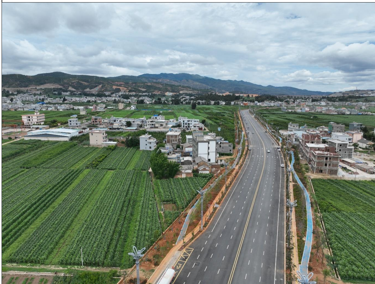
项目区道路路基路面现状
