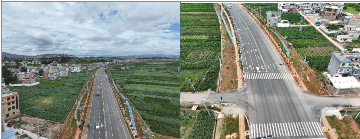
图 1-7 项目区道路现状情况
