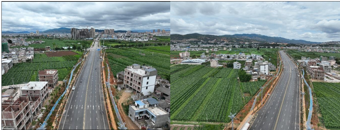
图 1-6 项目区道路现状情况
