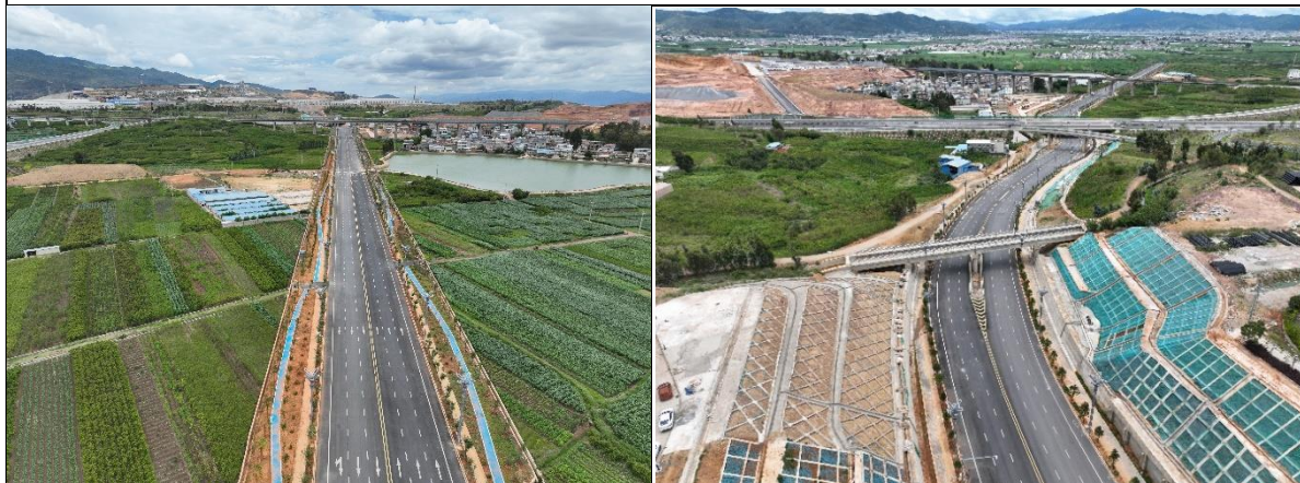
图 1-8 项目区道路现状情况
