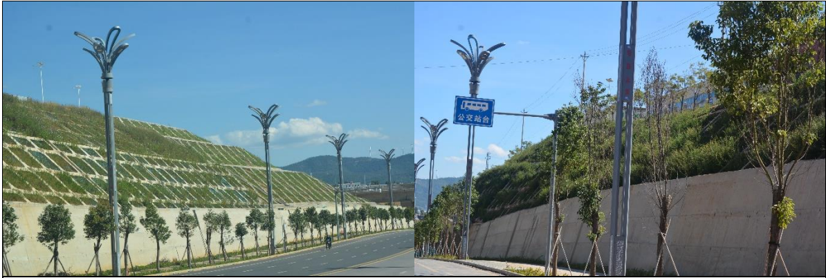
图 1-10 项目区道路边坡现状情况
