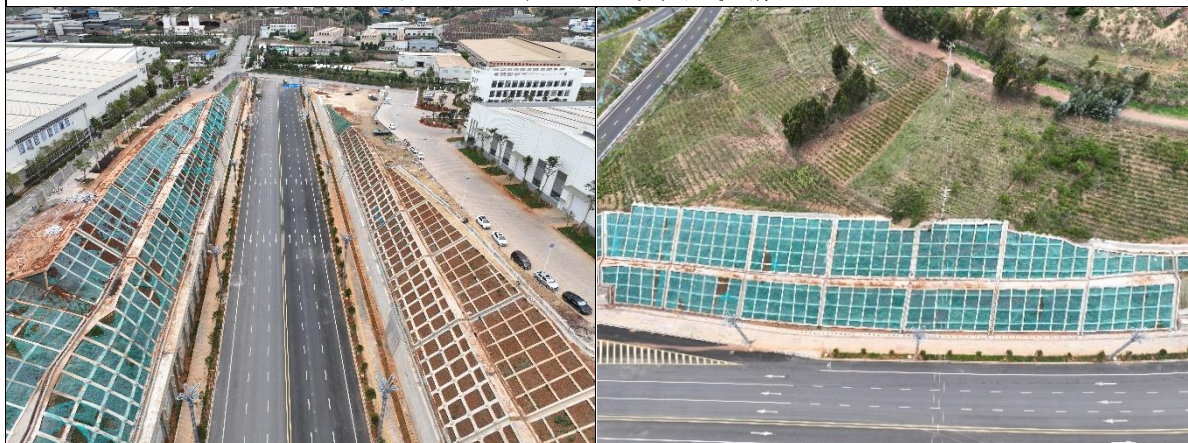
图 1-9 项目区道路现状情况
