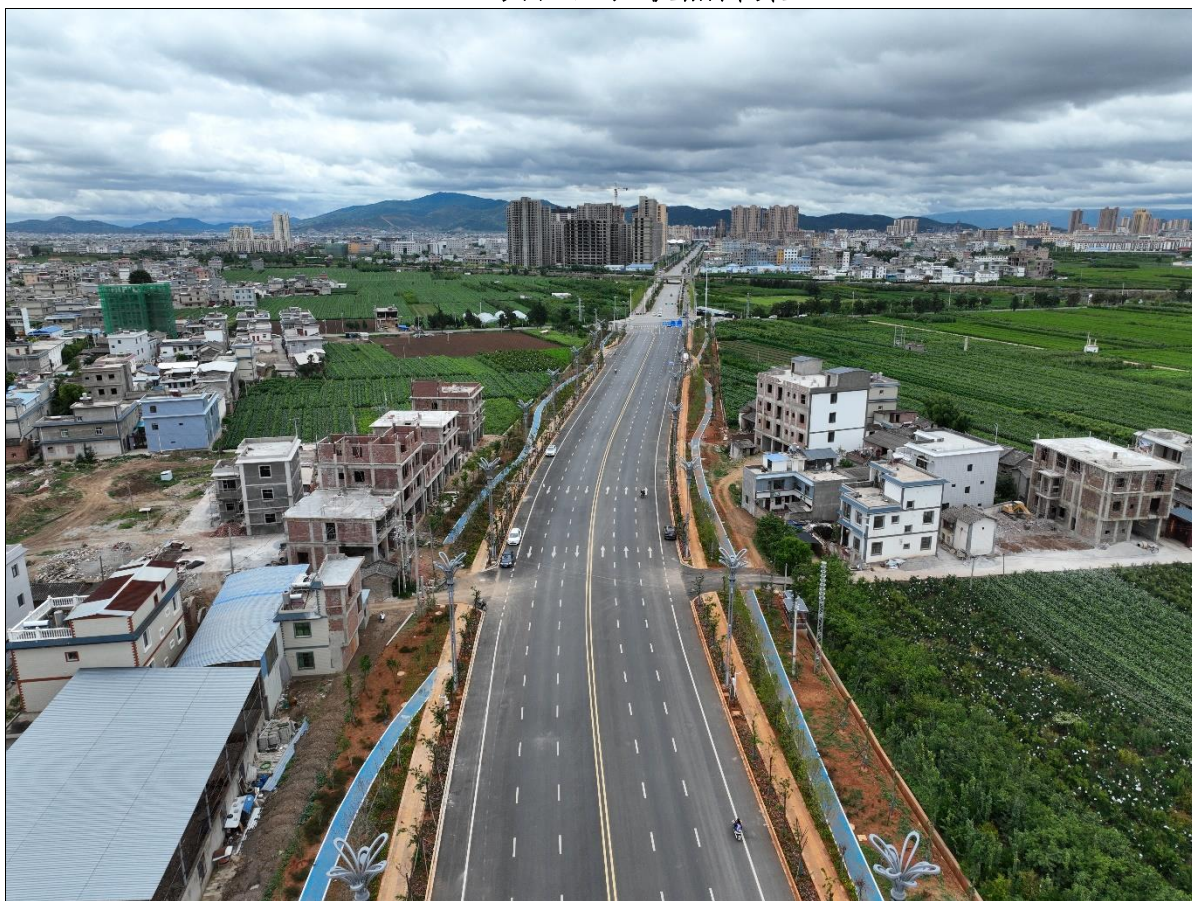
项目区道路路基路面现状
