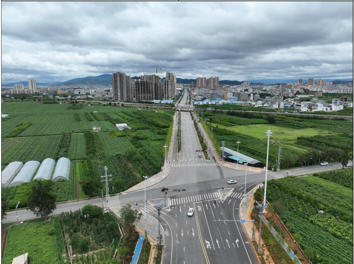
项目区起点连接道路现状
