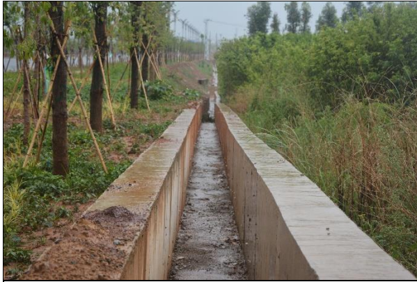
项目区排水沟现状
