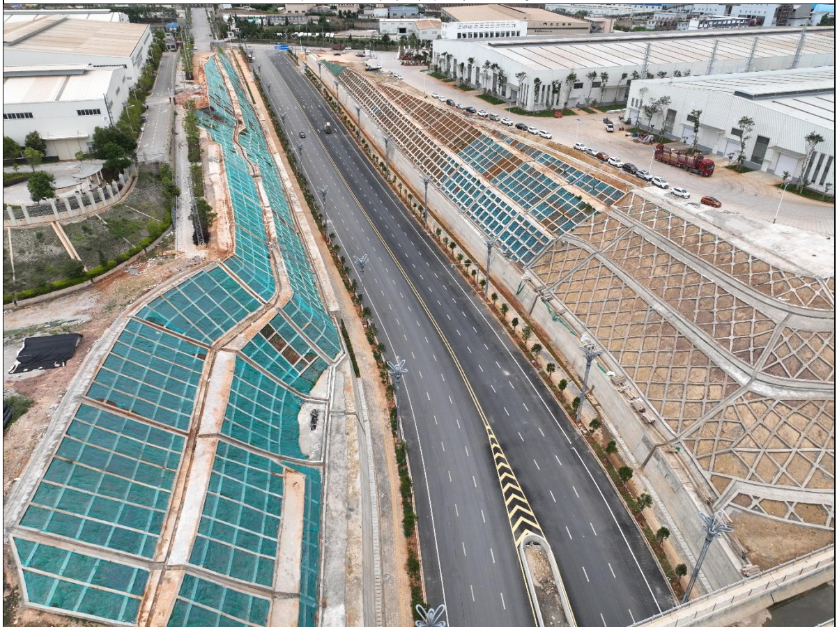
项目区道路路基路面现状
