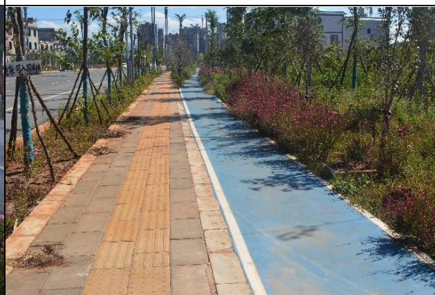
图 14 透水铺装（2023 年 10 月）
