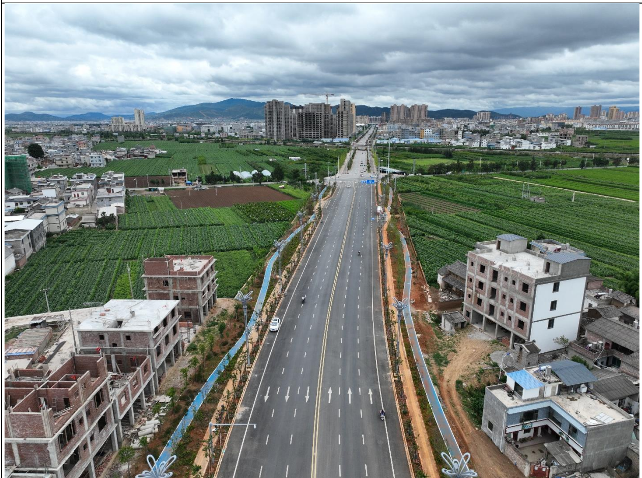
图 2 项目区道路工程现状（2023 年 9 月）
