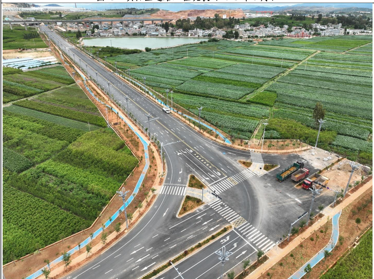
图 4 项目区道路工程现状（2023 年 9 月）
