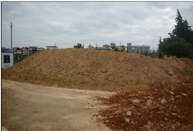
图 7 项目区路边堆存剥离表土（2022年9月）
