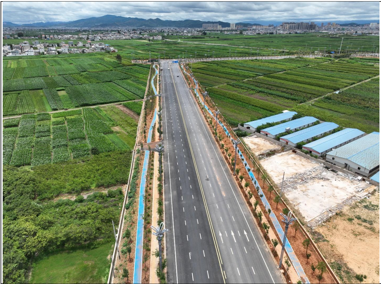
图 3 项目区道路工程现状（2023 年 9 月）
