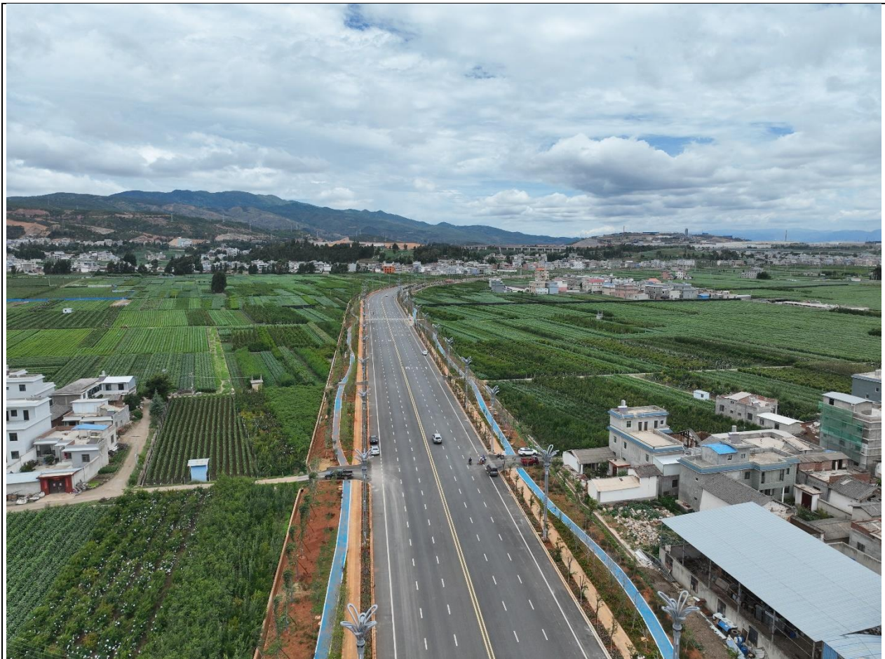
图 1 项目区道路工程现状（2023 年 9 月）
