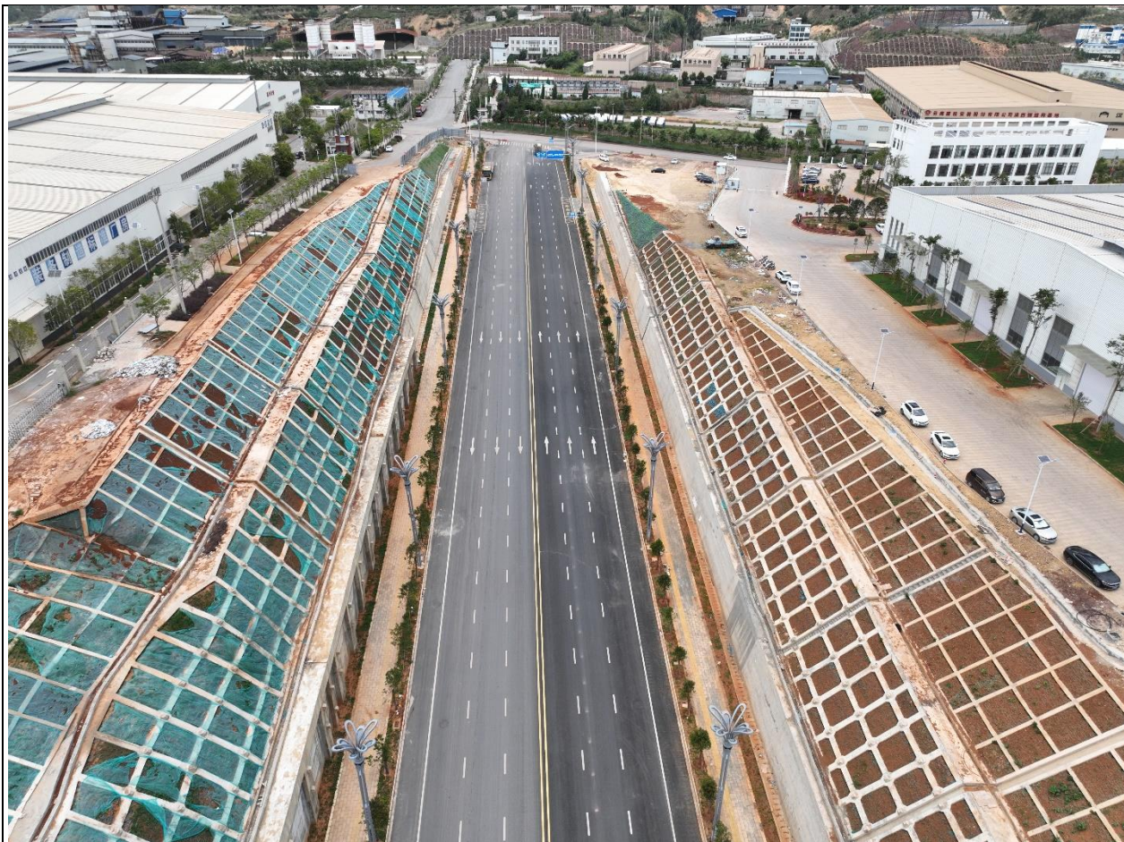
图 5 项目区道路工程现状 (2023 年 7 月)
