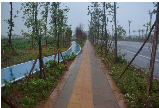
图 13 透水铺装（2023 年 7 月）
