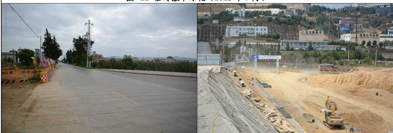
图 22 起点连接道路情况 (2022 年 9 月)
