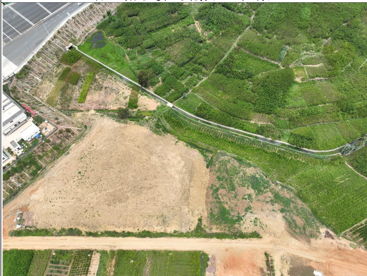
图 6 项目临时表土堆场现状 (2023 年 7 月)
