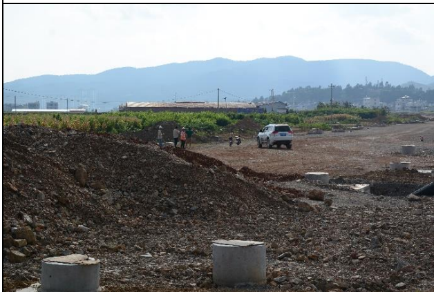
图 9 混凝土管铺设（2022年9月）
