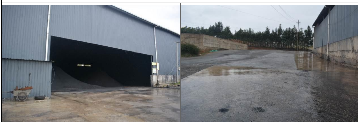
项目区已建雨落管及场地硬化现状情况
