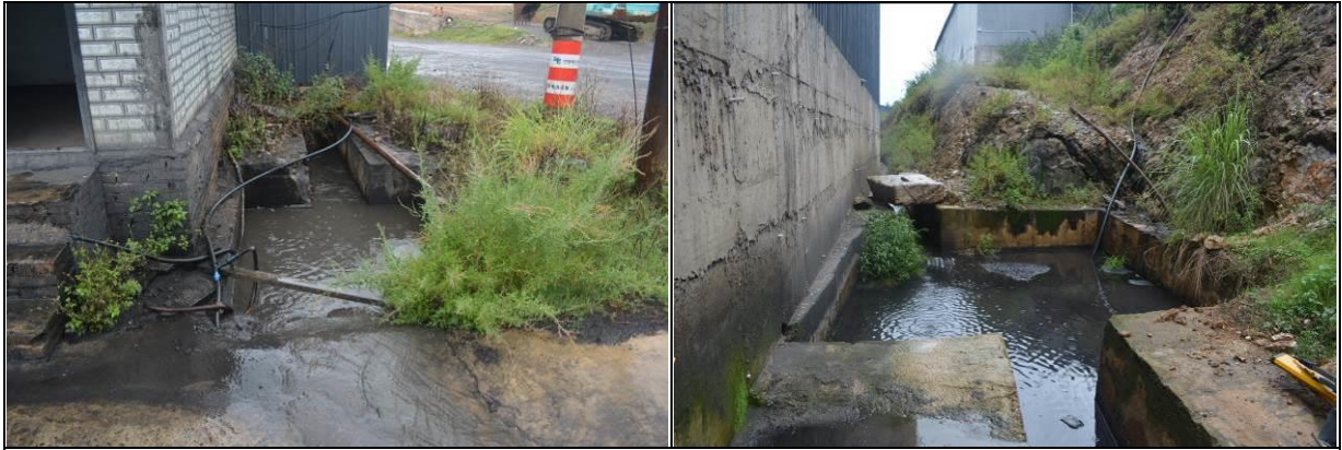
一期已建沉砂池现状情况
