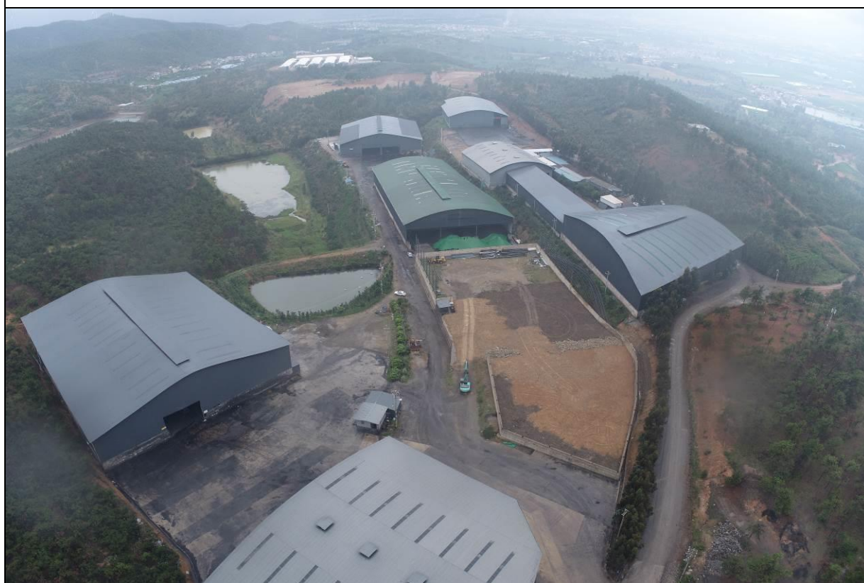
项目区现状情况（现已建成）
