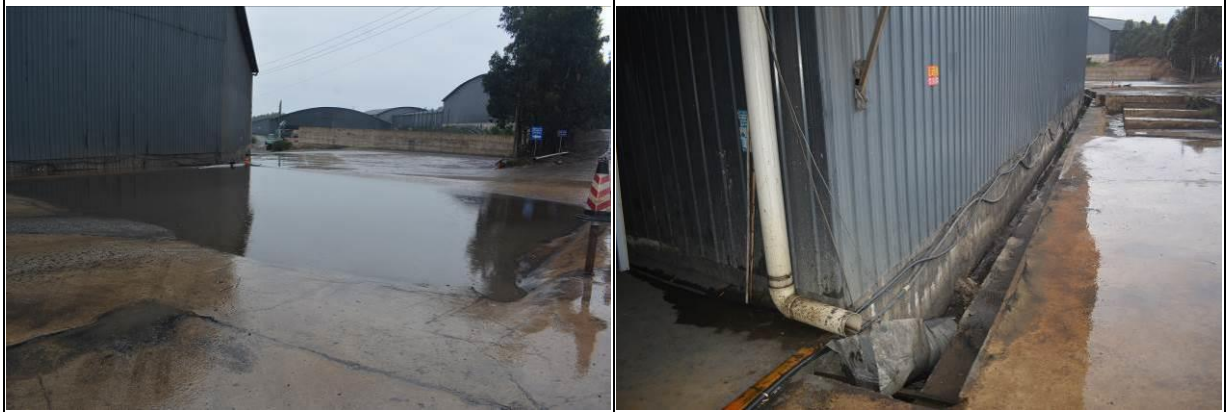
一期已建车辆清洗池及排水沟、雨落管现状情况
