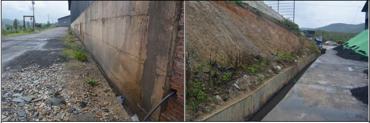
已建排水沟现状情况
