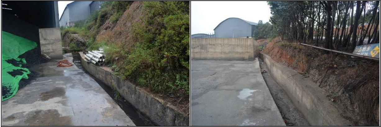
已建排水沟现状情况
