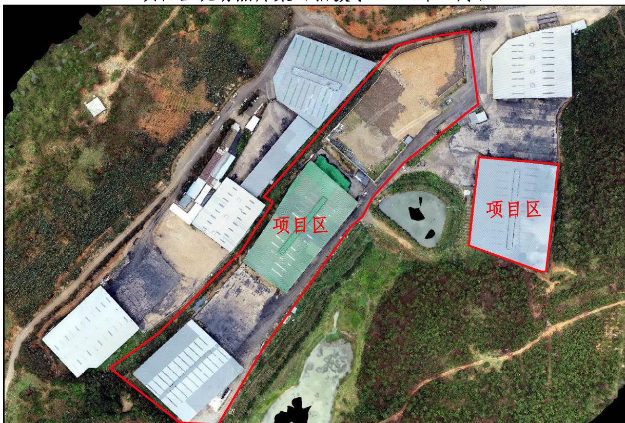
项目区范围及现状情况（正摄图）
