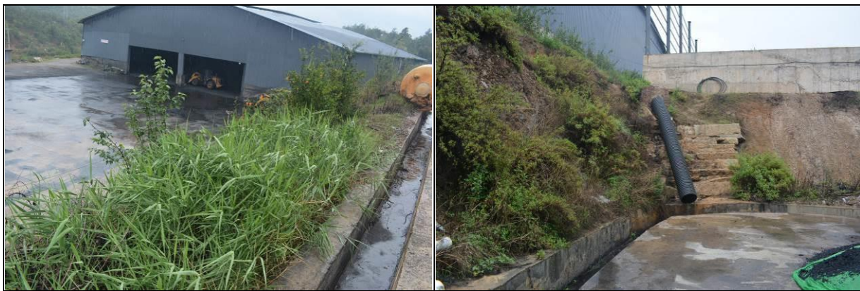
已建排水沟及植被绿化现状情况
