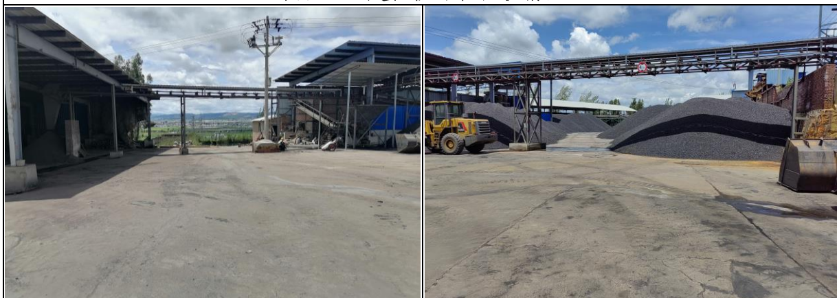
项目区已建场地硬化现状情况（原煤堆放裸露未覆盖）
