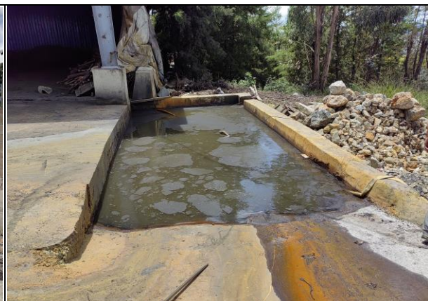
项目区已建循环水塘及车辆清洗池现状情况
