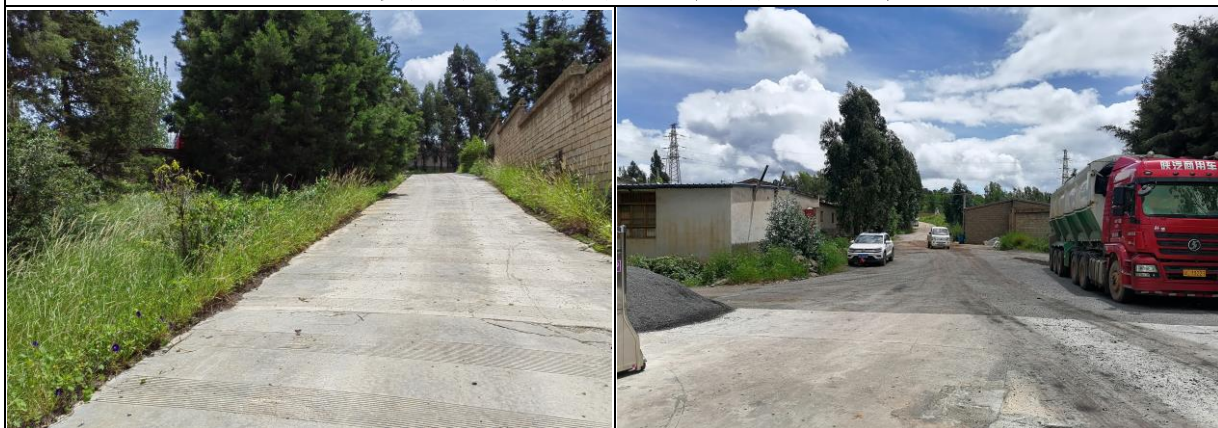
项目区出入口连接道路现状情况（路面混凝土硬化及碎石铺垫路面）
