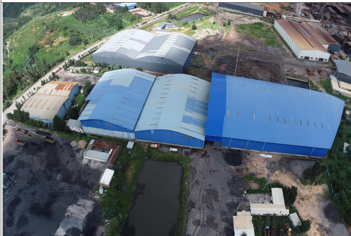
项目区现状情况（储煤仓库）
