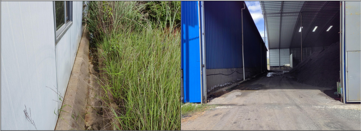
项目区已建排水沟及雨落管现状情况
