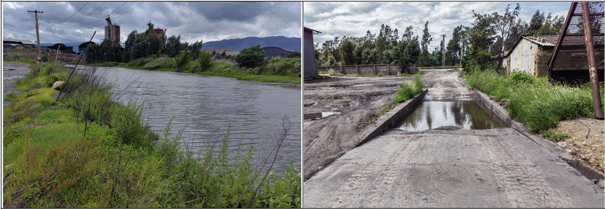
西北侧水塘以及项目区已建车辆清洗池现状情况
