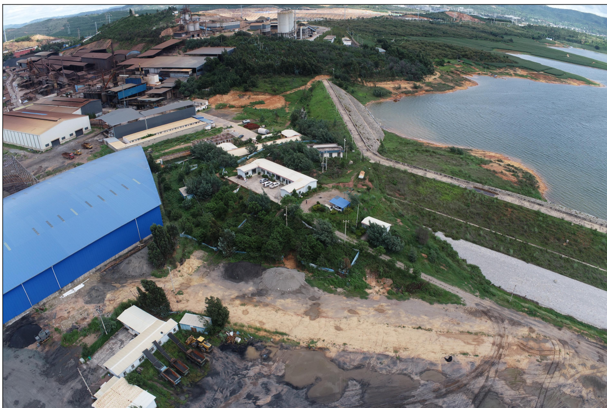
项目区办公生活区及西侧广场现状情况
