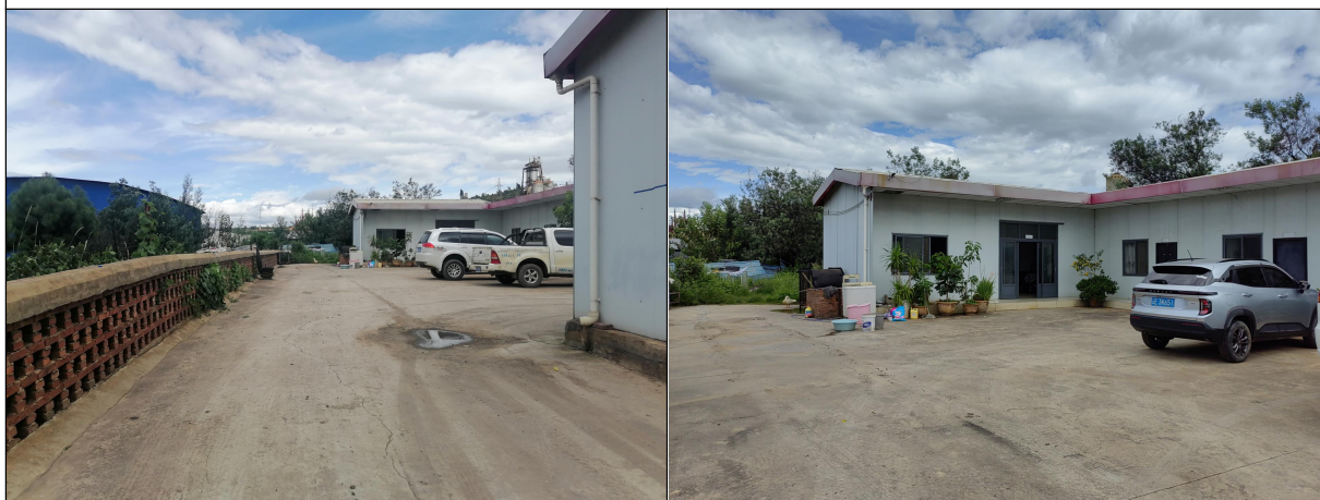
项目区已建道路及场地砼硬化现状情况
