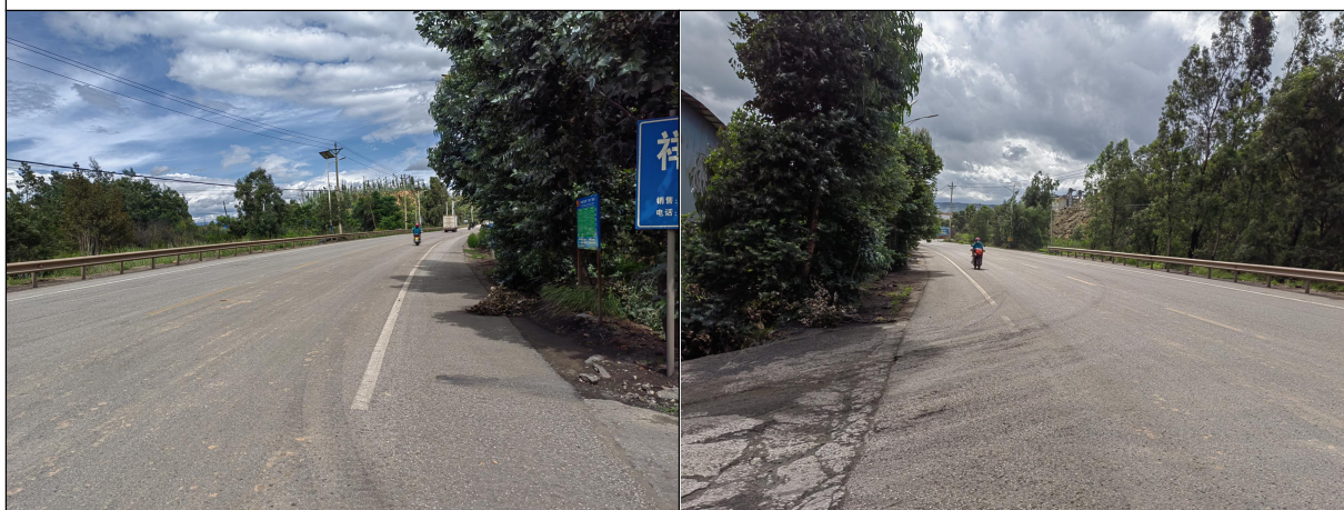
项目区周边道路现状情况（沥青混凝土）
