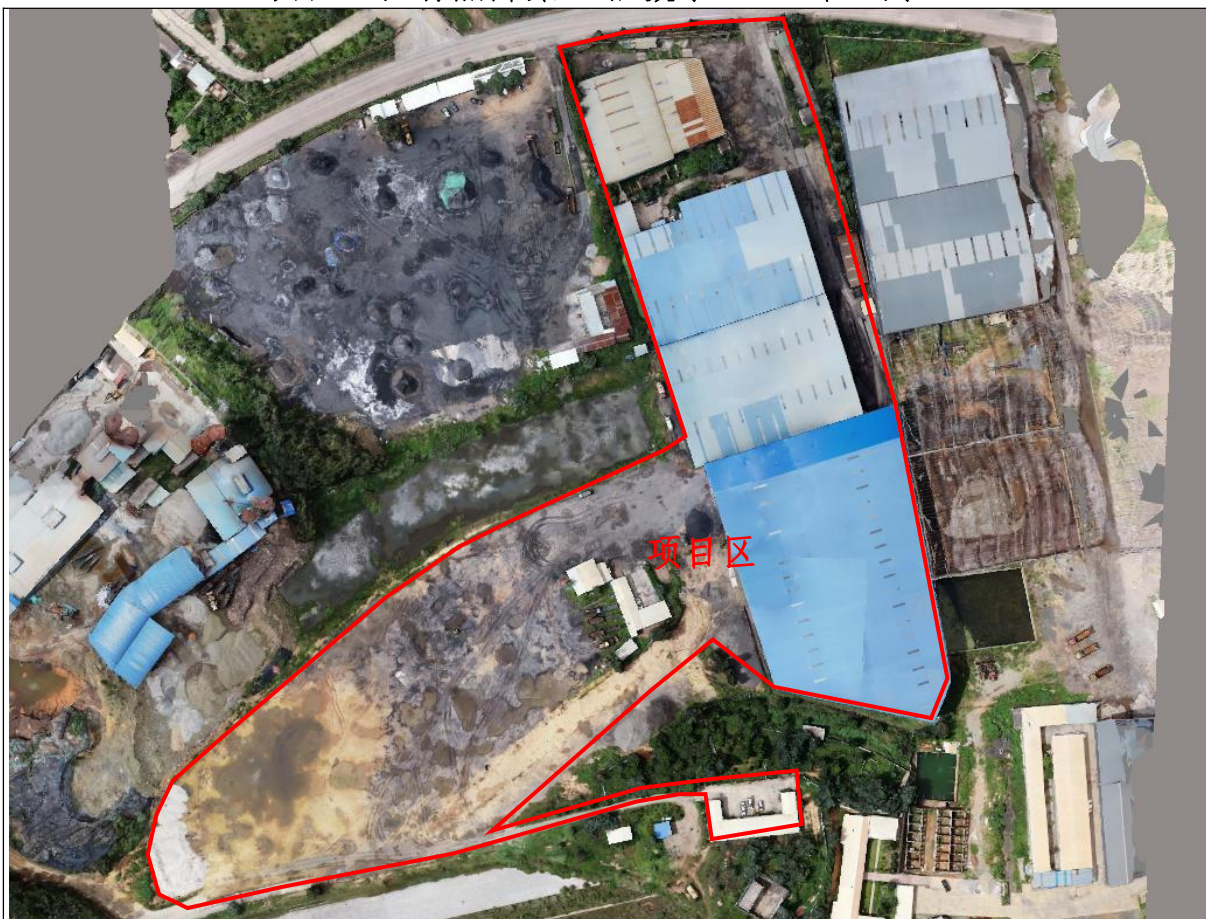
项目区现状情况（正摄图）
