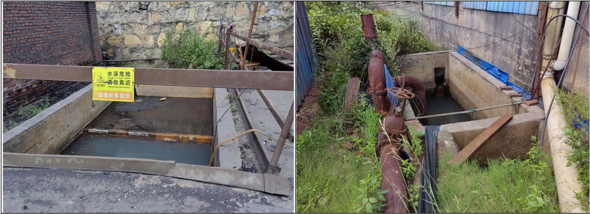
项目区已建沉淀池现状情况
