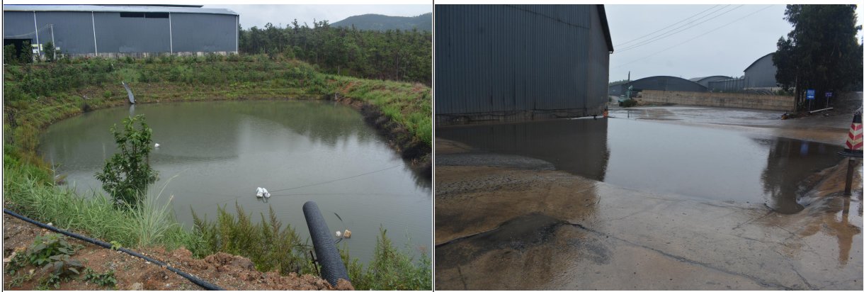
项目区已建生态塘及车辆清洗池现状情况
