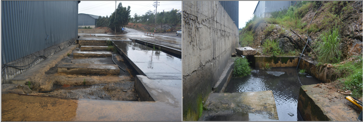
项目区已建沉砂池现状情况
