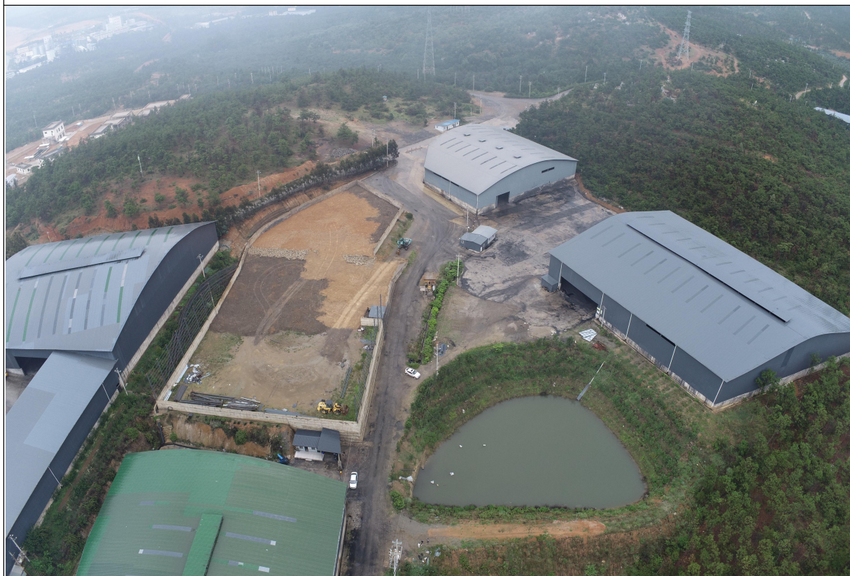
项目区现状情况（生态塘及 3# 储煤仓库）
