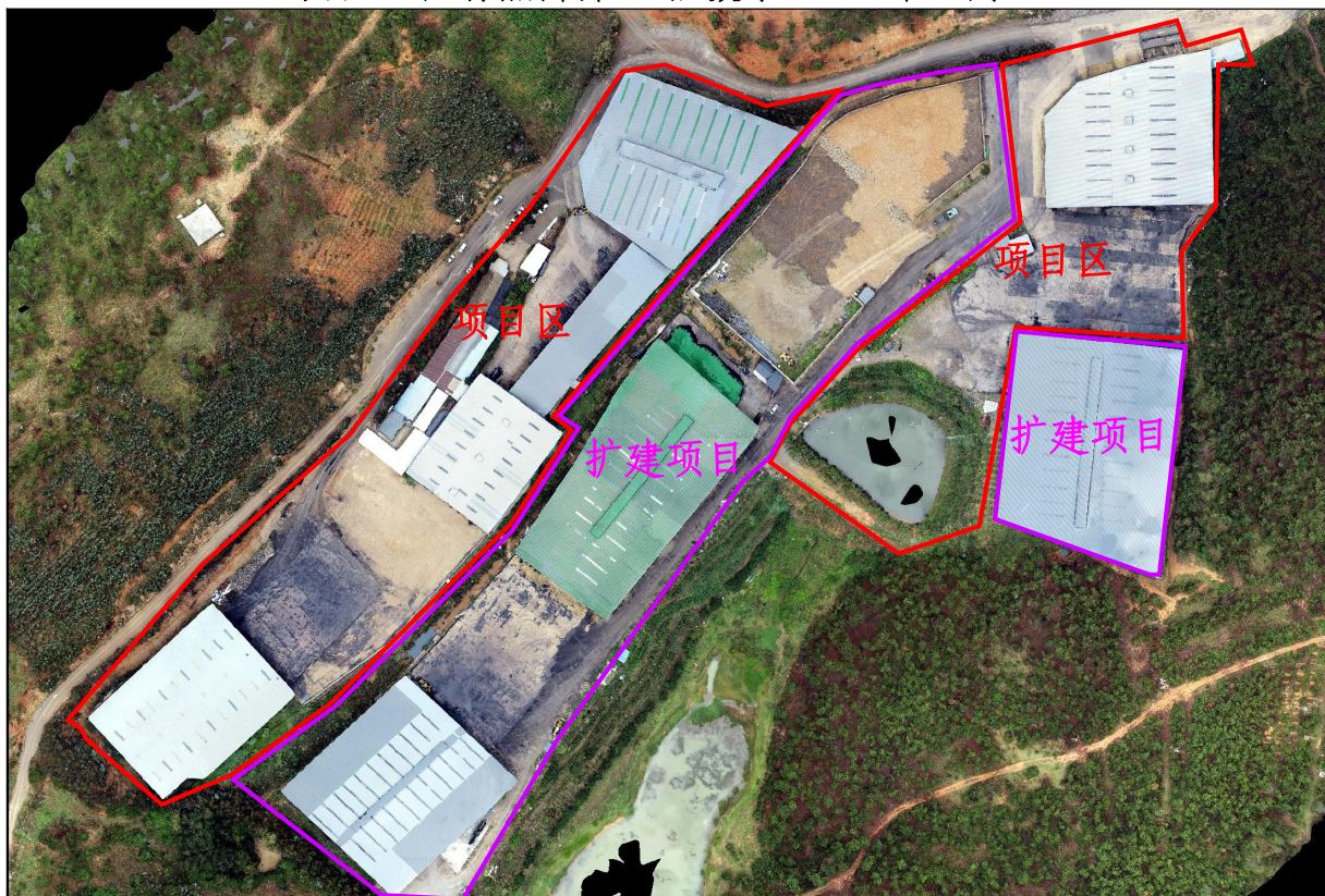
项目区现状情况（正摄图）
