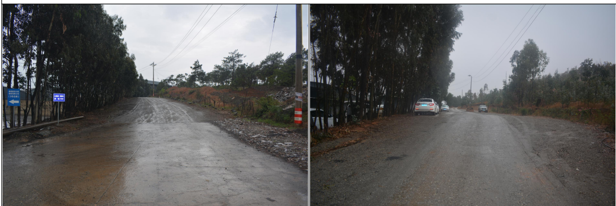
项目区出入口连接道路现状情况（路面混凝土硬化及碎石铺垫）
