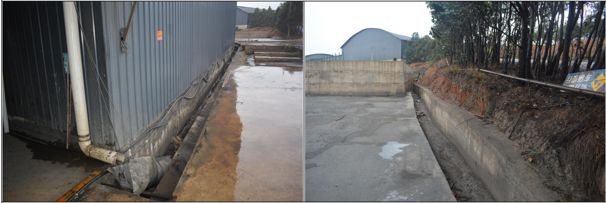
项目区已建排水沟及雨落管现状情况
