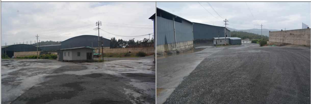
项目区已建场地硬化现状情况
