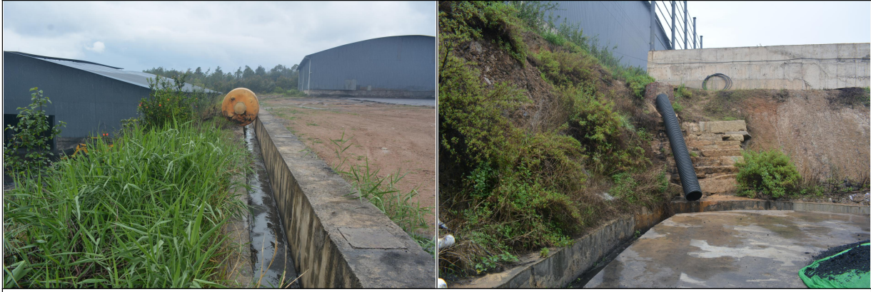
项目区已建排水沟及雨水管现状情况
