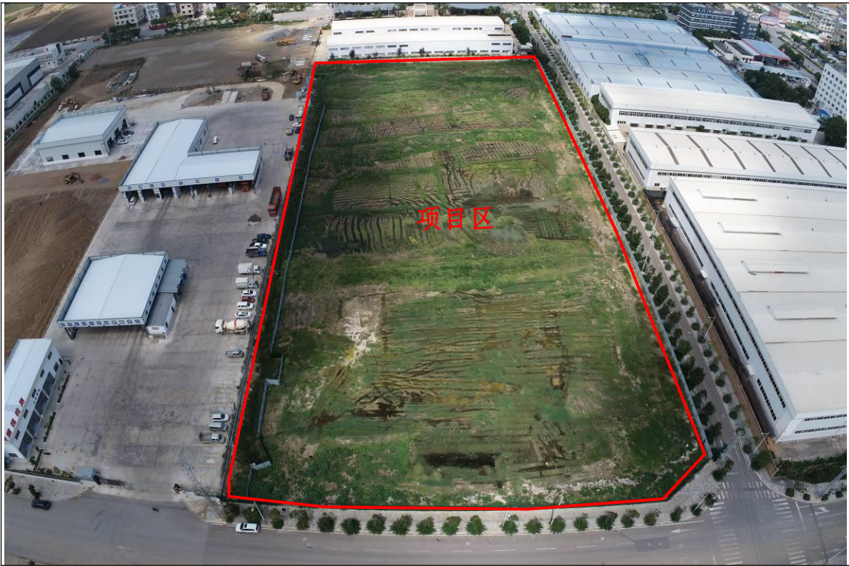
项目区现状情况
