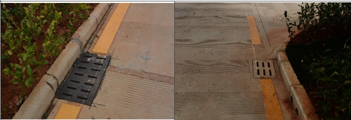
图 1-8 雨水口现状情况
