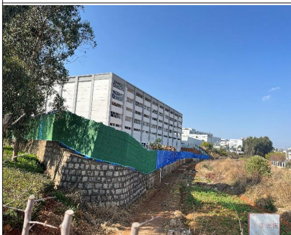
图 12 项目区施工期彩钢板围挡
