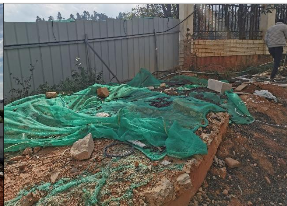
图 10 项目临时苫盖
