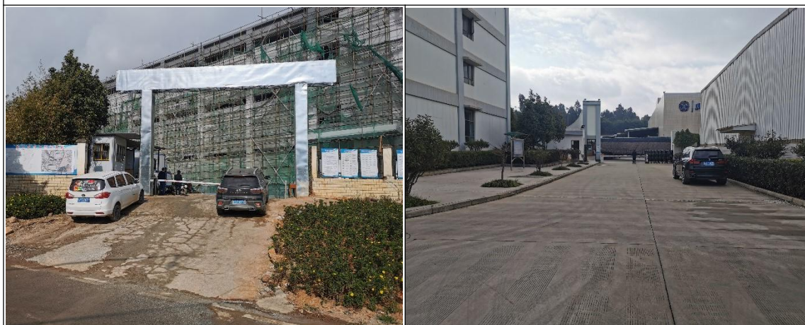
图 3 项目施工（已拆除）及运行出入口
