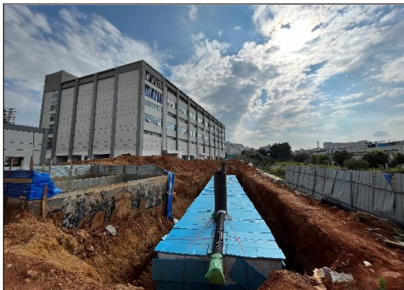
图 9 项目雨水收集池
