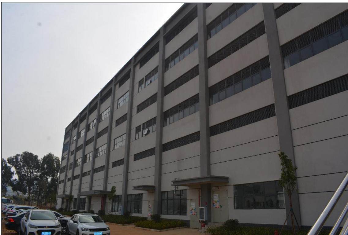
图 1 制剂车间二现状
