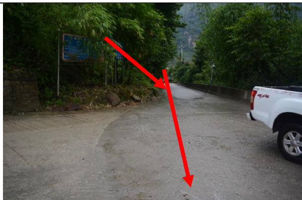
木古甲公路段（K1+903.209 交汇处）现状
