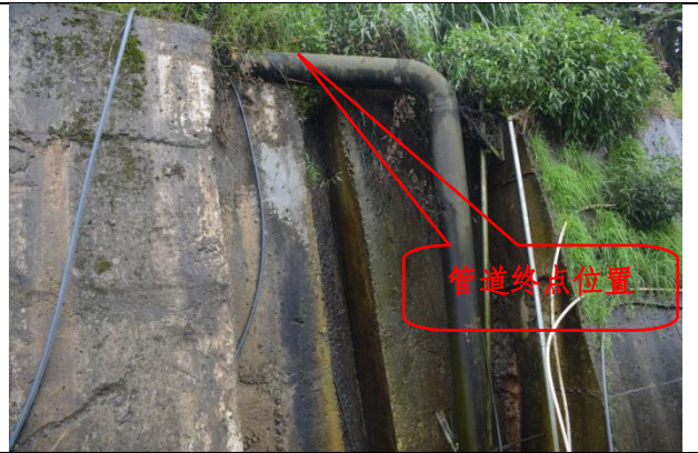
江东高位水池至美丽公路段管网工程终点现状
