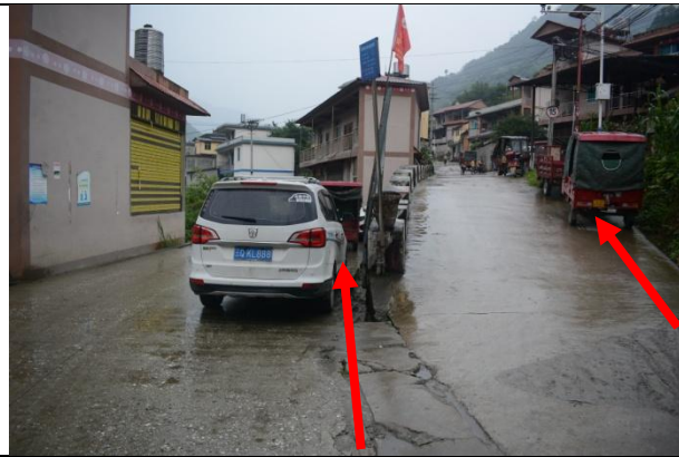
木古甲公路段 (K2+366.49 交汇处) 现状
