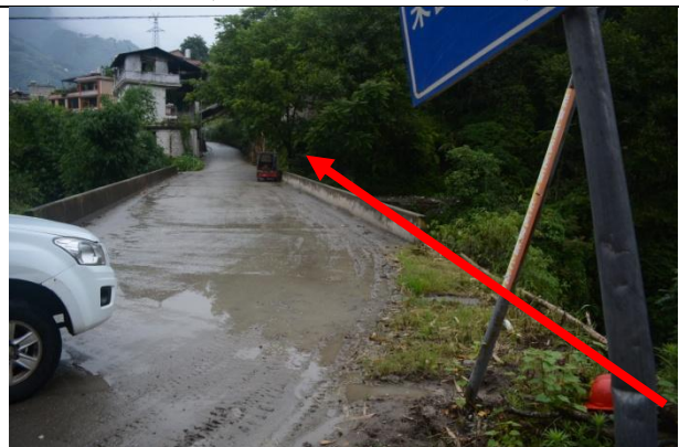
木古甲公路段（K1+961）现状（跨桥梁）
