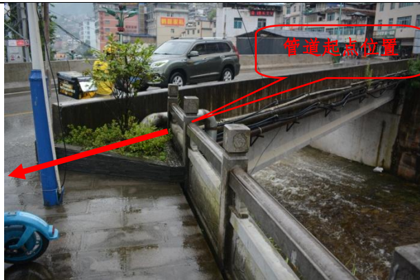
瓦贡公路段起点现状
