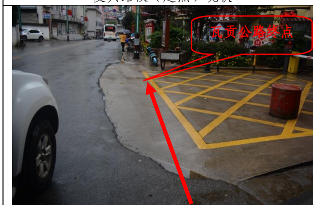
瓦贡公路段终点现状
