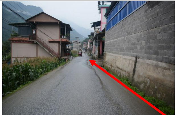
木古甲公路段（K1+448）现状
