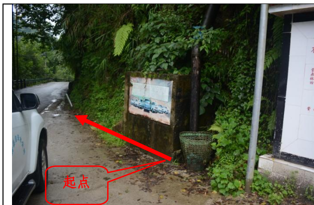
江西木古甲村管网起点现状（连接现状管道）
