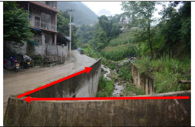
木古甲公路段 (K3+004.517 交汇处) 现状
