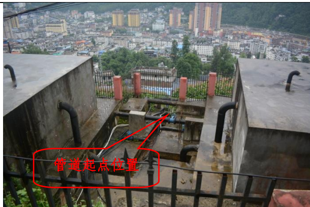
江东高位水池至美丽公路段管网工程起点现状
