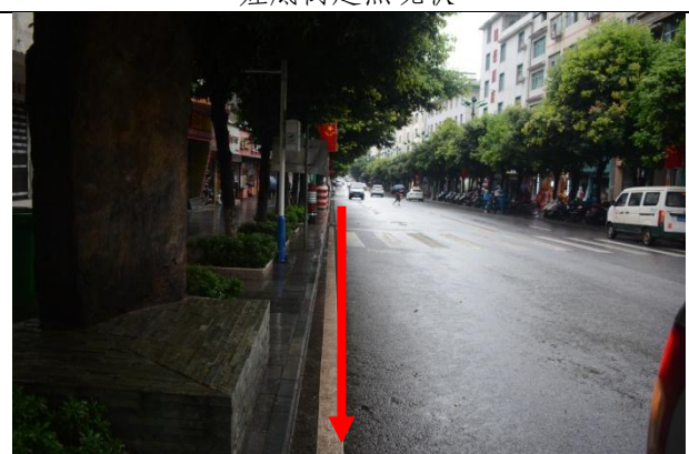
瓦贡公路段 (K0+700) 现状
