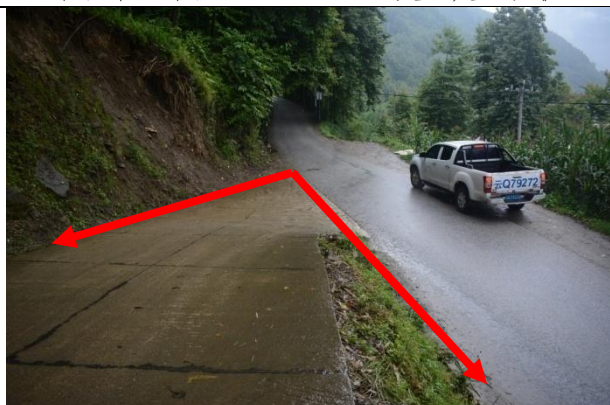
木古甲公路段（K1+273.375 交汇处）现状
