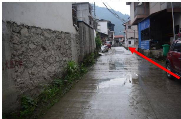
木古甲公路段（K2+056）现状
