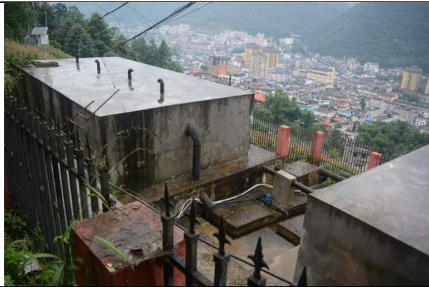
高位水池现状
