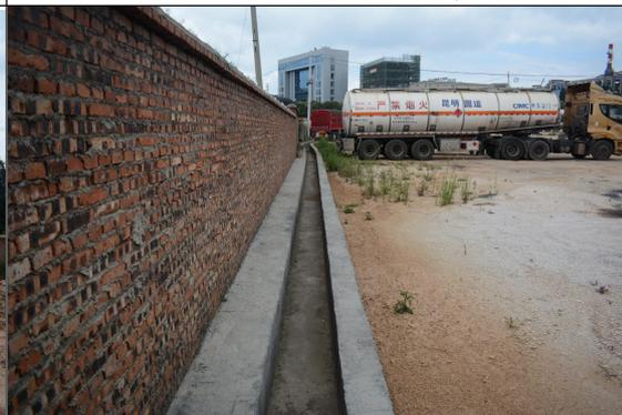
图 2-8 项目区排水沟（已经建设完）
