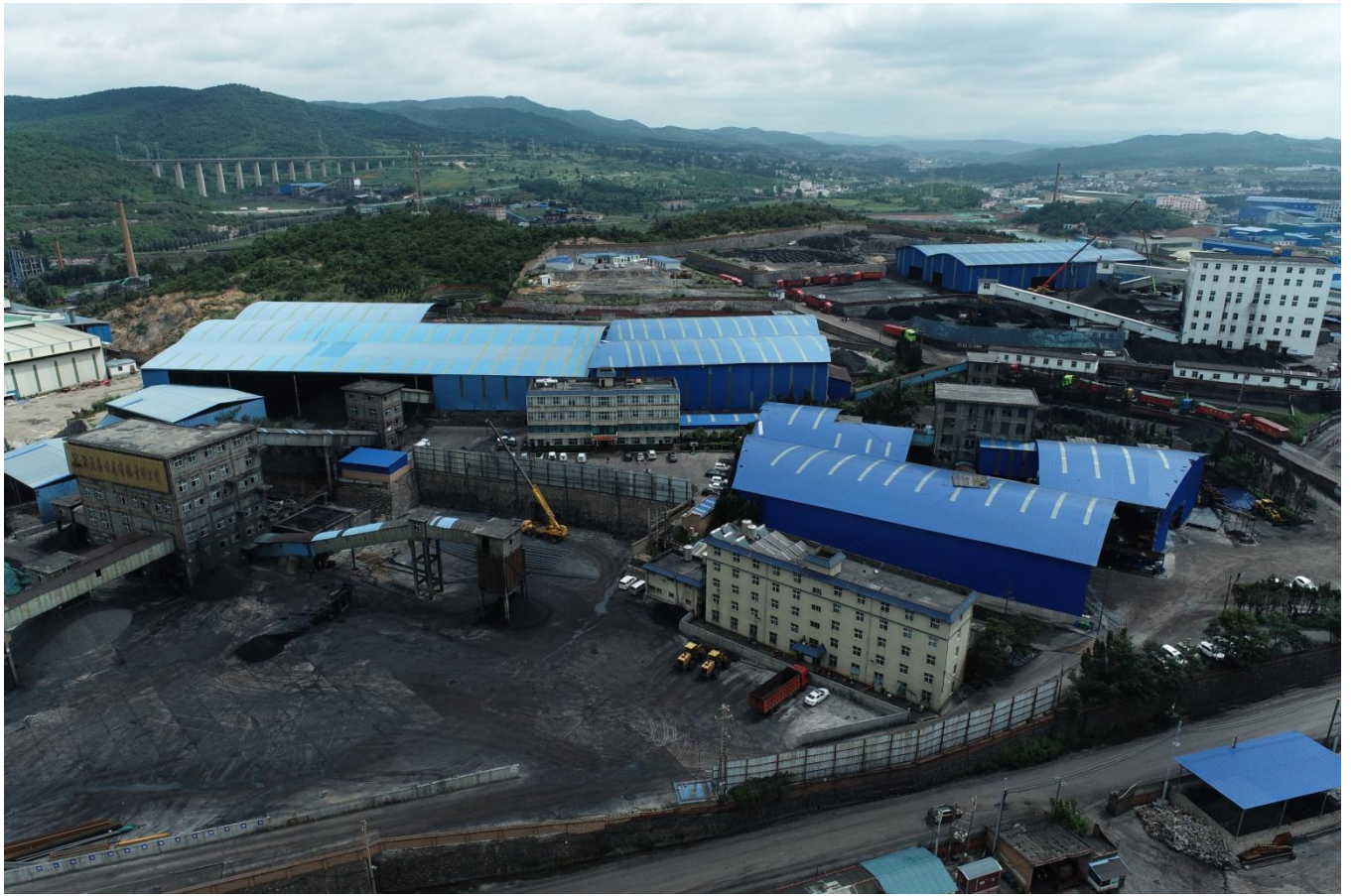
项目区航拍全景图
