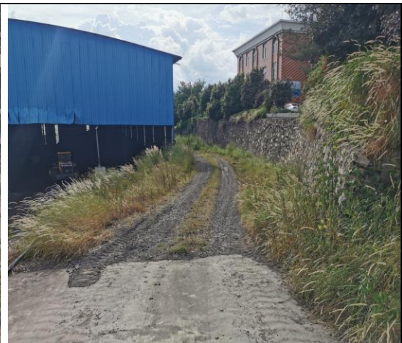
1#堆煤棚后方道路现状：泥结石路面，路宽 4.5m
