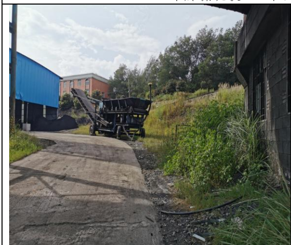
1#、4#堆煤棚之间道路现状：混凝土路面， 路宽约 4.5m
