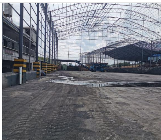
3#堆煤棚现状：正在对堆煤棚进行封闭处理
