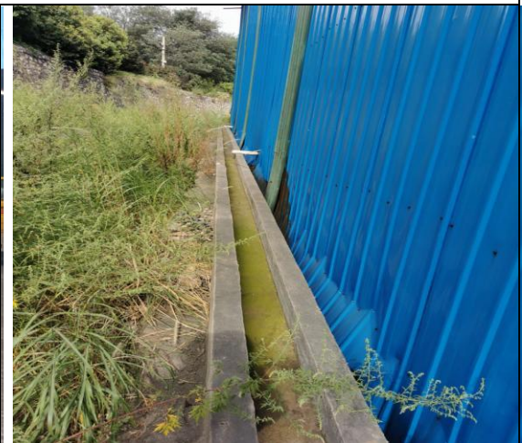
1#堆煤棚后方排水沟现状：砼排水沟 0.3 \times 0.2\text{m} ，运行情况良好，无损坏、淤积情况
