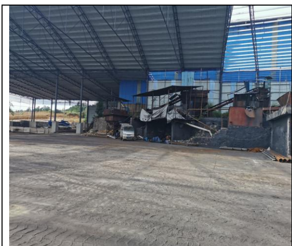
2#堆煤棚现状：正在对堆煤棚进行封闭处理
