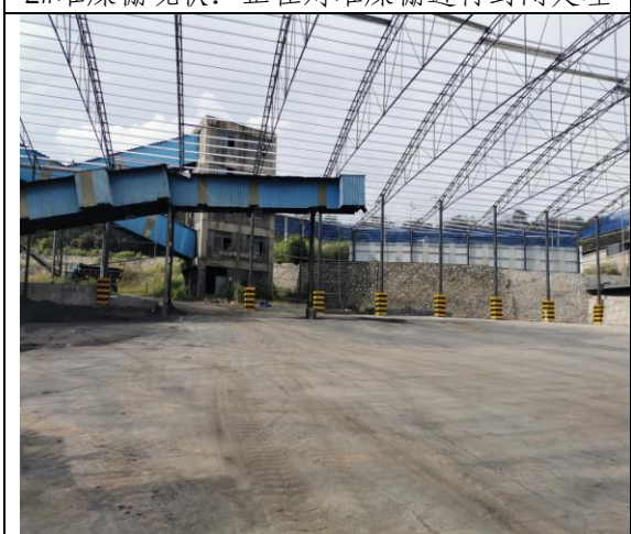
4#堆煤棚现状：正在对堆煤棚进行封闭处理
