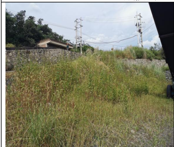
4#堆煤棚北侧绿化现状
