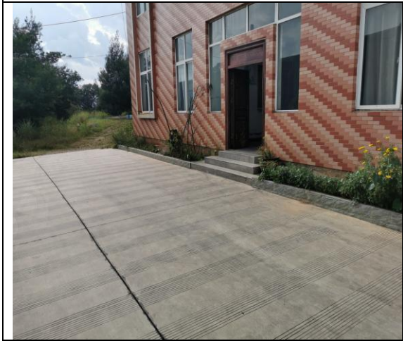
北侧生活楼现状：混凝土建筑，楼高 3 层
