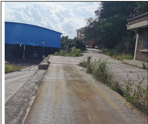
东北侧出入口至生活楼道路现状：混凝土路面，路宽 4~6m
